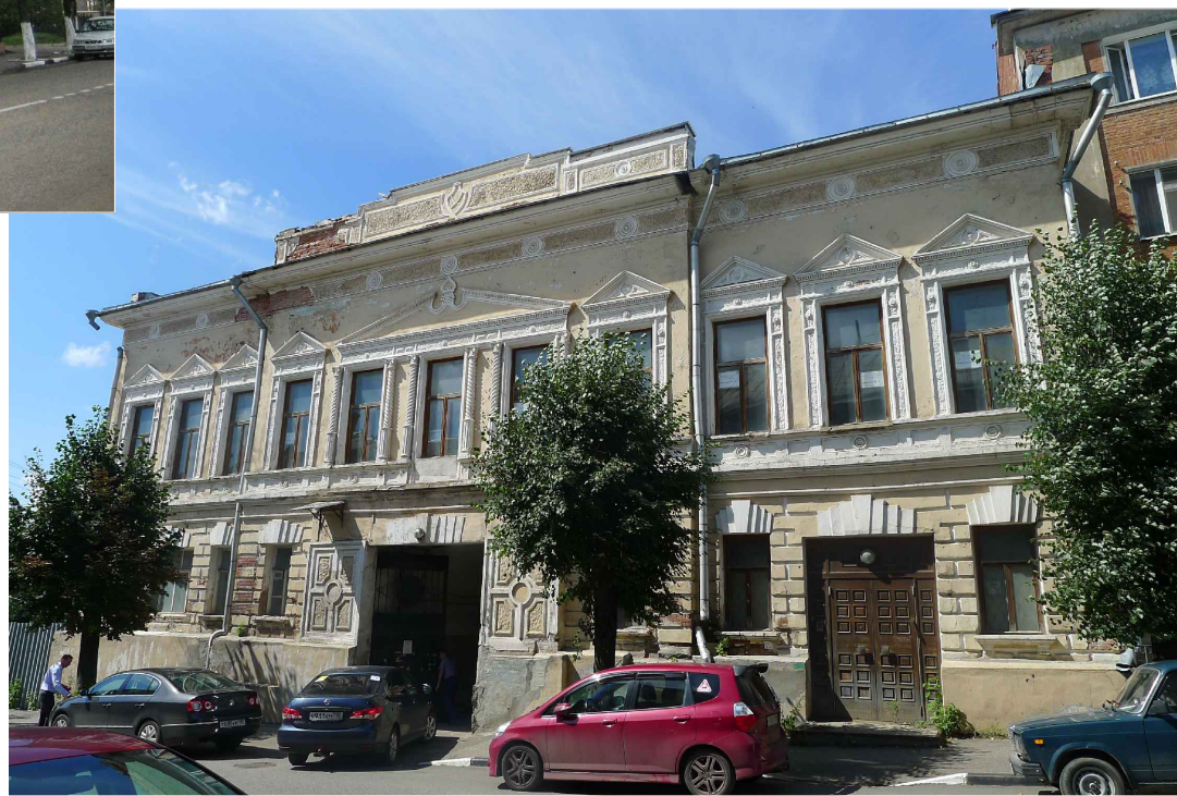
Вид с ул. Аристова. Главный фасад.
