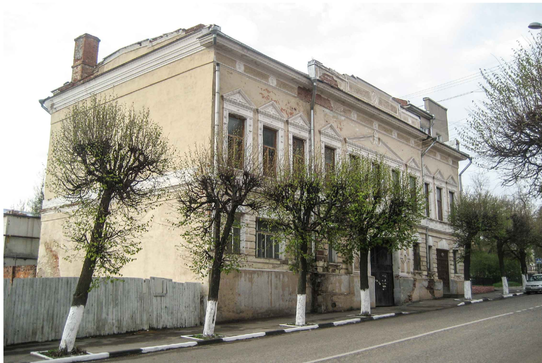
Вид с ул. Аристова. Главный фасад.
