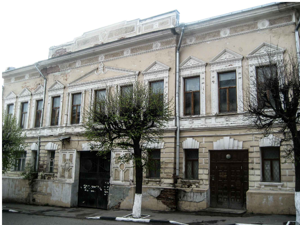
Вид с ул. Аристова. Фрагмент фасада.
